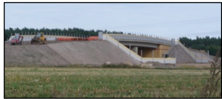
Im Bau befindliche Fledermausbrücke: Oben Stand 12/12; Mitte Stand 09/13; unten: Wolmirstedter Volksstimme 17.05.13
